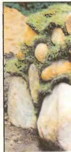
«Сухая» стенка из природных камней, выложенная с использованием рулонного дерна. Видимые пока щели со временем затянутся.
