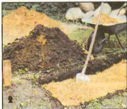
2 Песок разравнивают граблями и тщательно утрамбовывают. При устройстве более высоких стенок к песку можно добавить тощий бетон.
