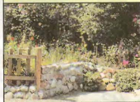
В саду, окультуренном «под природу», стенка может выглядеть несколько строже. На этой стенке, выложенной на растворе, мало растений.
