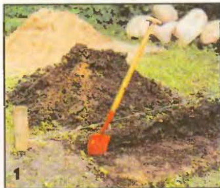
1 В траншею отсыпают слой песка, который хорошо пропускает воду.
